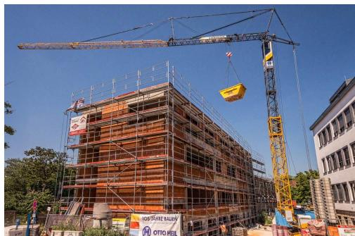
Der Neubau der David-Schuster-Realschule mit insgesamt 4 Vollgeschossen besteht aus einem ersten und zweiten Untergeschoss, Erdgeschoss, ersten und zweiten Obergeschoss. Das zweite Untergeschoss ist nur teilunterkellert und verschwindet vollständig im Erdreich.
