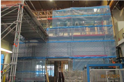
Die Arbeiten wurden im laufenden Betrieb in der Industrie nach genauem Bauablaufplan unter Berücksichtigung der zusätzlichen Arbeiten aufgrund abweichender Verhältnisse durchgeführt. Hierbei wurden Wände abgebrochen und an anderer Stelle neue Wände in Kalksandstein Sichtmauerwerk erstellt. Die vorhandenen Sanitäreanlagen wurden abgebrochen und durch neue Anlagen ersetzt. Durch Umstrukturierung wurden in einer hohe Produktionshalle zwei neue Stahlbetondecken bei laufender Produktion erstellt.
