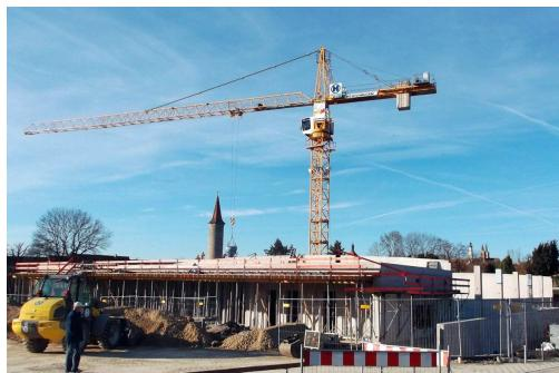
Der Neubau ist in Massivbauweise mit tragenden Wandscheiben und Stützen aus Beton gebaut. Die Stützen sind als Fertigteile in Köcherfundamente eingestellt. Die Decken über Geräte- und Technikräume im UG und die der Umkleidetrakte im EG wurden als Filigrandecken ausgeführt.
