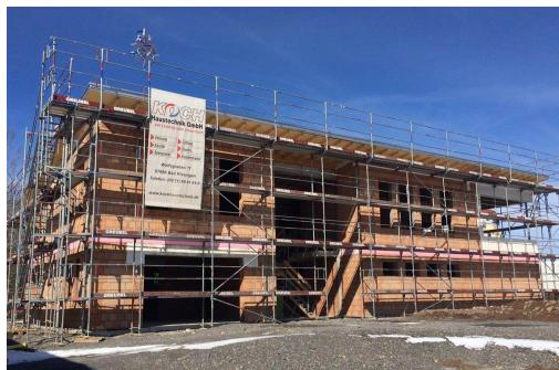
Im Maria-Ward-Weg, am Rand der ehemaligen US-Kaserne, entsteht für 1,8 Mio. Euro die neue Unterkunft für den THW-Ortsverband Bad Kissingen. Der Neubau beinhaltet ein Verwaltungsgebäude in Massivbauweise sowie der Fundamente und Bodenplatte für eine KFZ-Halle in Stahlbetonweise. Die Planung, ausschließlich der Haustechnik, erfolgte durch das Staatliche Bauamt Schweinfurt. Trotz belastetem Boden kam es zu keinen zeitlichen Verzögerungen.
