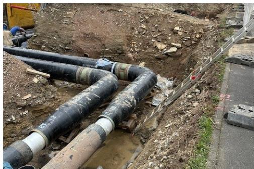
Im Zuge des Ausbaus des Fernwärmennetzes am Hubland in Würzburg musste ein Ausdehnungsbogen eingebaut werden, um die Wärmeausdehnung des Rohrnetzes kompensieren zu können.
