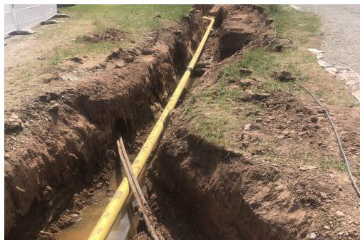
In Großenbrach im Landkreis Bad Kissingen ist eine Brückensanierung geplant. Im Zuge dessen, musste eine Gashochdruckleitung verlegt und wieder an den Bestand angeschlossen werden.
