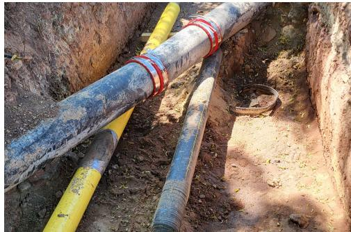
Im Vorfeld der Sanierung der Südbrücke und einer Kanalmaßnahme in Bad Kissingen musste auf der östlichen Saaleseite neben einer Tennishalle die vorhandene Gashochdruckleitung umgelegt und an drei Stellen wieder eingebaut werden.
