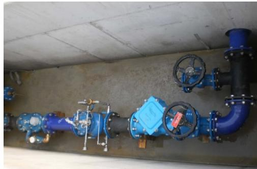
Herstellen eines Betonschachtes inkl. dem Einbau eines Rohrsystems aus duktilem Gusseisen und deren Armaturen zur Steuerung und Minderung des ankommenden Wasserdrucks zur Versorgung eines Wohngebietes.
