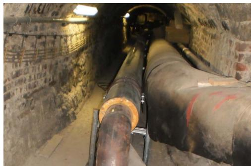
Neuverlegung der Rücklaufleitung im Pleichachkanal. Unter beengten Platzverhältnissen wurden im Pleichachkanal in Würzburg Fernwärmeleitungen verlegt. Die Arbeiten wurden unter erhöhten Sicherheitsvorschriften durchgeführt.
