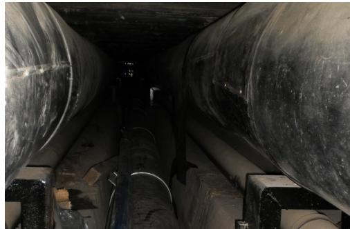
Neuverlegung einer Fernwärmeleitung im bestehenden Heizkanal unter besengten Bedingungen.
