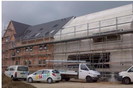
Das bestehende Rathaus wurde entkernt und ein Anbau erstellt. Der komplette Anbau wurde in Sichtbetonqualität SB 4 ausgeführt und verfügt über ein betoniertes Satteldach. In diesem Anbau wurden Foyer, Archiv, Verwaltungsräume und der Sitzungssaal eingerichtet. Im Neubau des Nebengebäudes (Bauhof) sind die Heizungsanlage inklusive dem Hackschnitzelbunker, Büro-, Aufenthalts-, und Sanitärräume untergebracht. Im Bereich der Außenanlagen wurden umfangreiche Entwässerungsleitungen verlegt.
