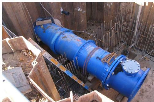
Im Rahmen des Ausbaus der ICE-Strecke von Bahn-Km 16,700 bis 18,000 wurde in Unterleiterbach die Fernwasserleitung DN 700 GGGZM, PN 25, umverlegt. Die alte Wasserleitung einschließlich Widerlager und Entlüfterschacht wurden ausgebaut. Ein neuer Entlüfterschacht wurde errichtet.
