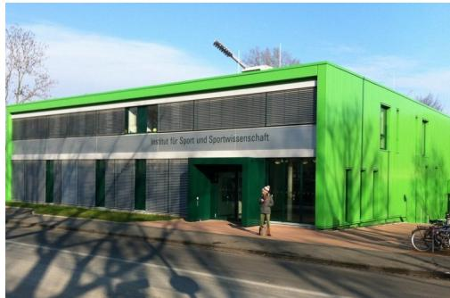
Ausgeführt wurde der Neubau des Institutgebäudes für Sportwissenschaften als Anbau an die Mehrfeldgroßsporthalle der Universität Kassel neben dem Auestadion. Hierfür wurden Abbrucharbeiten, Erdarbeiten, Kampfmittelberäumung und die Stahlbetonarbeiten in Sichtbetonklasse 2 ausgeführt. Es handelt sich um ein zweigeschossiges Gebäude mit Aufzug und Treppenhaus. Zur Stabilisierung des nichttragfähigen Bodens wurden 90 Fertigteil-rammpfähle mit einem 75 Tonnen schweren Rammgerät eingebracht.
