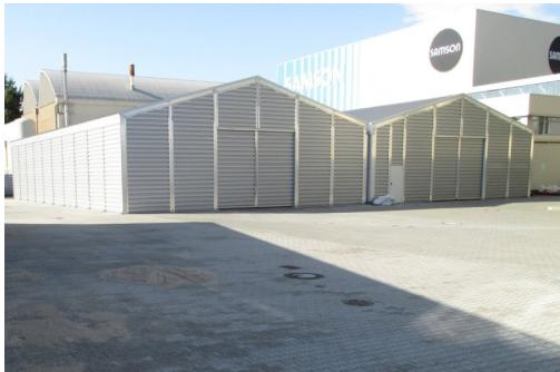
Die Samson AG hat ein auf ihrem Werksgelände nicht genutztes Stück Gelände hergerichtet, um darauf zwei Lagerhallen zu errichten. Dazu wurde das Gelände ausgekoffert, Regenwasserkänele und eine Versickerung/Rigole eingebaut. Die Flächen außerhalb der Hallen wurden gepflastert und in einer Halle eine bewehrte Bodenplatte hergestellt.
