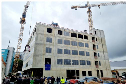
Der Institutsneubau für das Fraunhofer-Institut für Translationale Medizin und Pharmakologie (ITMP) verfügt über 5 oberirdische Geschosse, sowie einem Staffelgeschoss für die Technikzentrale. Das Gebäude enthält neben einer eigenen Mitarbeiter-Cafeteria mehrere Labor-, Forschungs- und Bürobereiche mit einem zentralen Innenhof in den oberen Geschossen.
