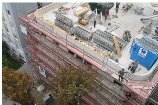
Erstellung einer Radioonkologie in Ortbetonweise.
