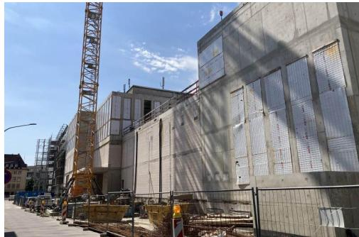
Für die Generalsanierung des Gebäudes wurden großen Teile des Hinterhauses abgebrochen und in Stahlbeton-Bauweise in Kombination mit KS-Mauerwerk neuerrichtet.
