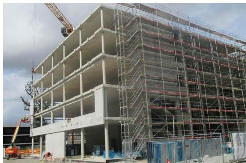
Das Bauwerk hat einen quadratischen Grundriss bei einer Außenfläche 34 x 34 m. Die Konstruktion wurde in Massivbauweise als Stahlbetonkonstruktion errichtet. Das Gebäude besteht aus zwei Untergeschoßen und fünf aufgehenden Geschoßen.
