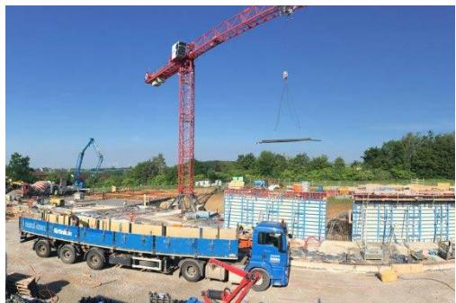
Die Baumaßnahme umfasst den Neubau einer Grund- und Mittelschule mit Hort. Das Gebäude besteht aus drei Flügeln, die ein Erd- und ein Obergeschoss beinhalten. Eine spätere Aufstockung ist möglich. Die Stahlbetonskelettbauweise bietet viel Platz für große Fenster. Die Schule wird über eine moderne Betonkerntemperierung beheizt.
