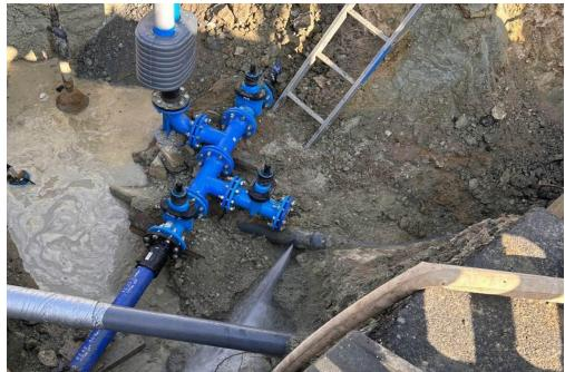
Um die Versorgungssicherheit zu erhöhen wurde die Wasserhauptleitung am Mühlberg in Küps erneuert. Im Zuge dessen erfolgte die Umbindung sämtlicher Wasserhausanschlüsse. Um die Verlegung der geplanten Leitungstrasse zu ermöglichen, waren zudem Erdarbeiten für den Rohrgrabenauhub und die anschließende Wiederverfüllung erforderlich. Hierbei wurden auch die Oberflächen komplett wiederhergestellt.
