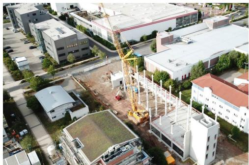
Die Firma Laboklin in Bad Kissingen hat im 3. Bauabschnitt ihre zwei bestehenden Laborgebäude um ein drittes erweitert. Das neue Bürogebäude wurde überwiegend in Fertigteilbauweise errichtet.
