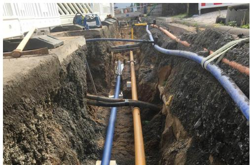
Die alte PVC-Gasleitung wurde gegen eine neue PE-Gasleitung ausgetauscht. Im Zuge dessen wurde ebenfalls die Wasserleitung in einem Stufengraben neu verlegt.
